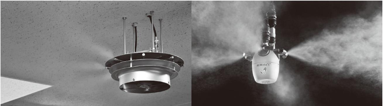
写真 一流体加湿システム（左）と二流体加湿システム
