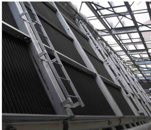
図1 蒸気復水器の外観
